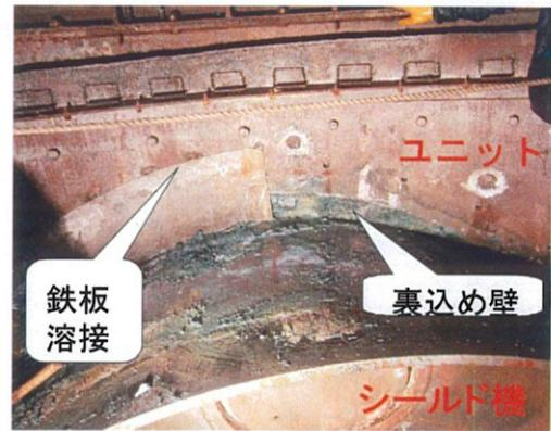
図一 12. 裏込め充填及び止水鉄板溶接
