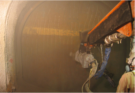
写真－５ 吹付け状況 (遠心力吹付け方式)
