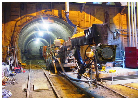
写真－5 小断面トンネル吹付けシステム
