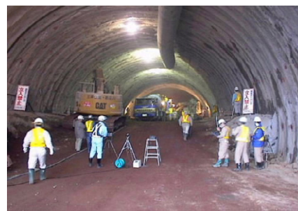
写真-3 粉じん濃度計測状況
