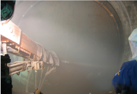
写真－６ 吹付け状況 (エア吹付け方式)
