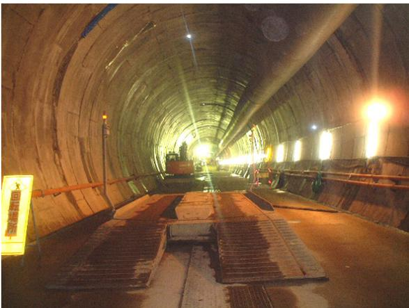
写真-5 一次覆工コンクリート打設完了
