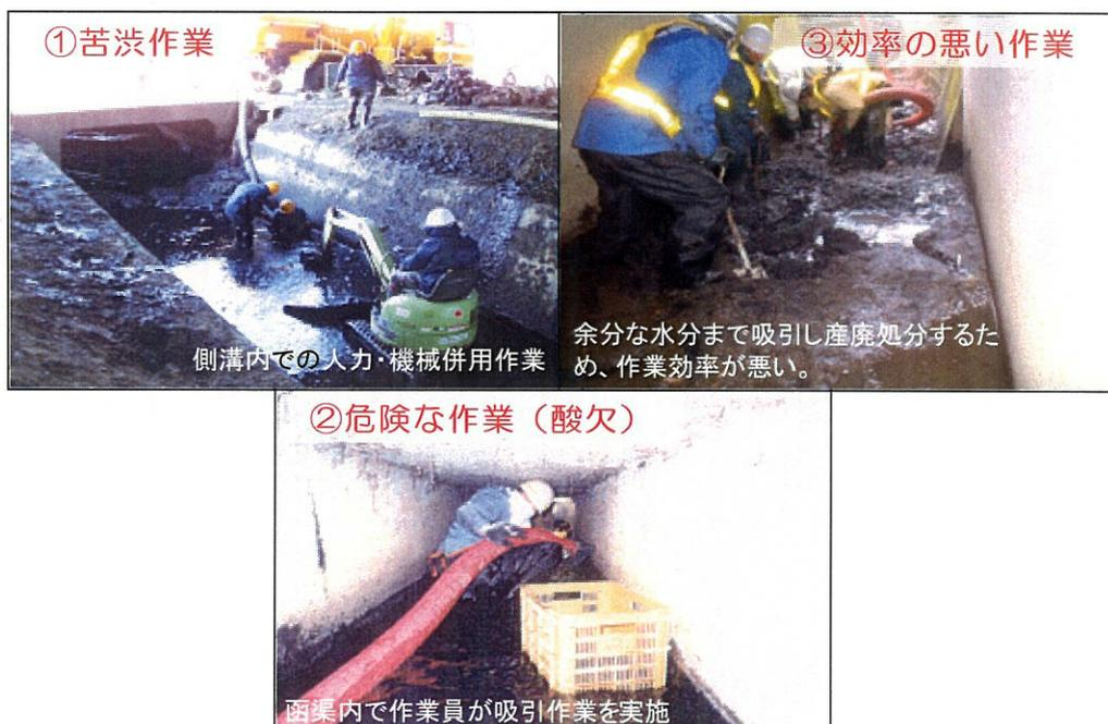
写真－1 函渠・側溝清掃作業の現状
