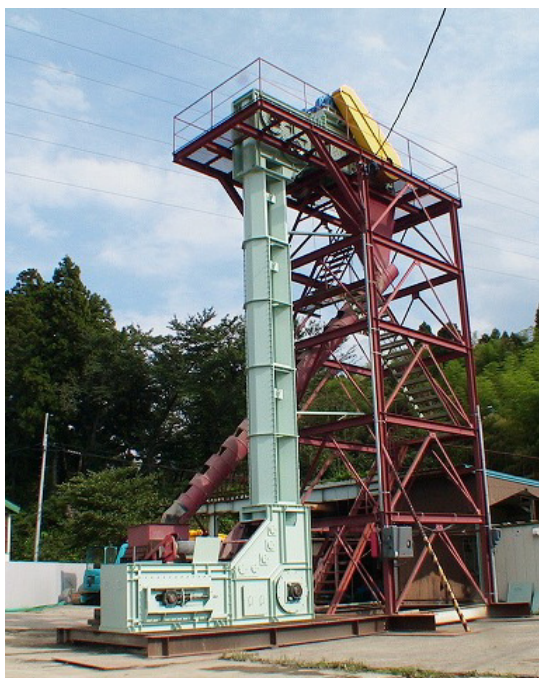
写真－1 実験装置設置状況
