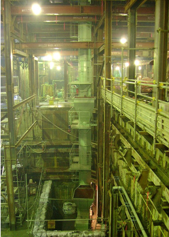
写真－3 装置設置状況
