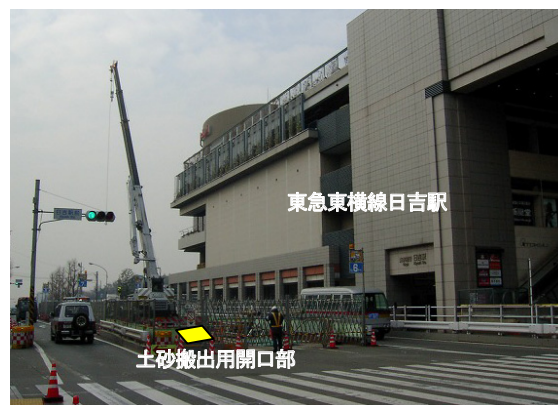
写真－2 土砂搬出場所全景
