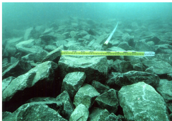
Fig.13 作業後のマウンド状況
