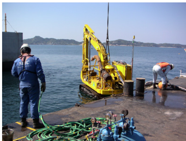
Fig.11 バックホウ投入状況
