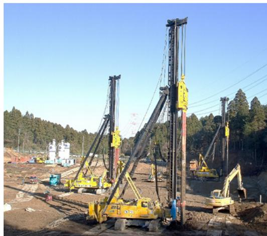
写真-3 レムニ2/3工法の施工状況
