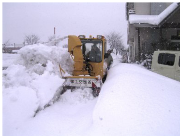
写真-1 狭い歩道上での除雪作業
