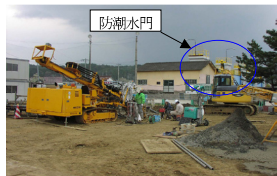
写真-7 施工状況（水門右岸）
