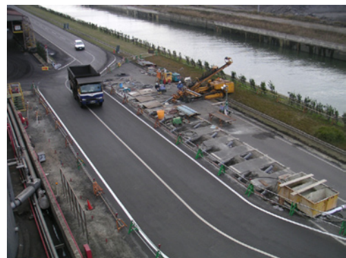
写真－5 施工状況 2
