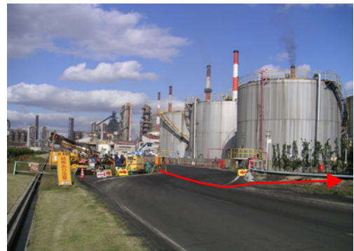
写真－4 施工状況 1
