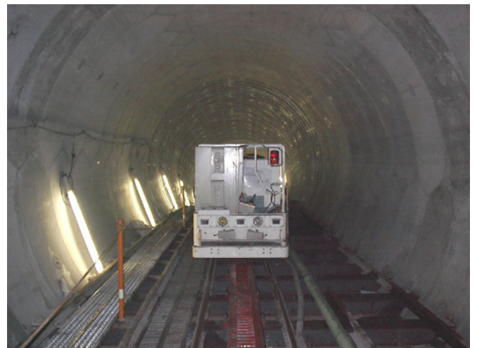
写真—4 サーボロコ急勾配を行く
