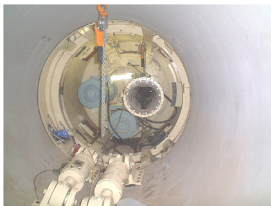
写真-5. 方向修正ジャッキ他解体状況
