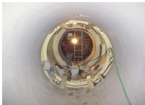
写真-7. 外殻－駆動部切離し完了
