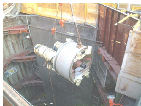
写真－１２. 駆動部引揚げ状況(発進立坑部)
