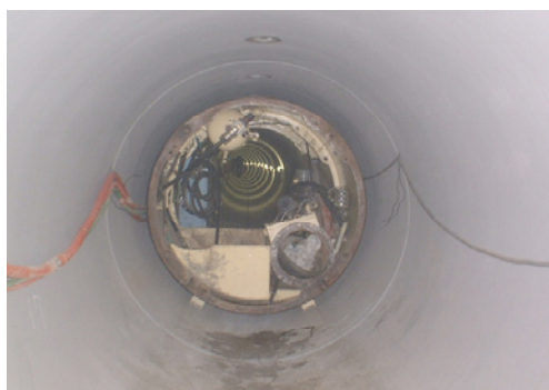
写真－９. 後続管引戻し状況(到達側より)
