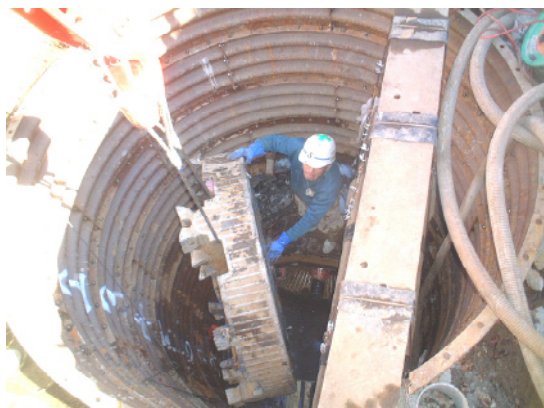
写真-4. 面盤解体引揚げ状況
