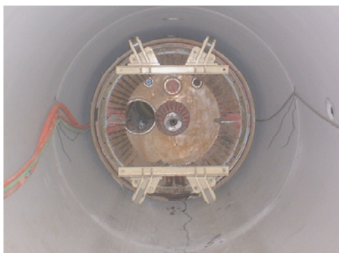
写真－１０. 駆動部引戻し状況(到達側より)
