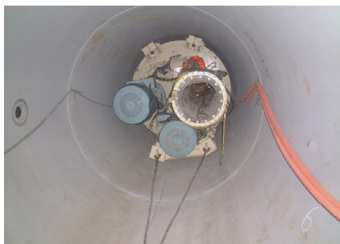
写真－１１. 駆動部引戻し状況(発進側より)
