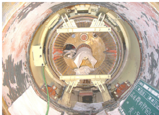
写真-6. 外殻－駆動部切離し
