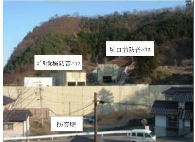
写真-1 坑外防音設備
