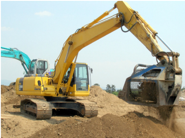
図－5 ふるい機稼動状況
