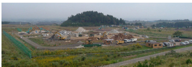
図－２ 集積場全景写真
