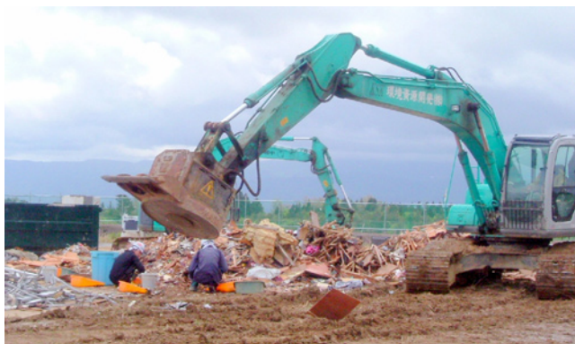
図 7 重機（マグネット）と人力併用の一次選別作業
