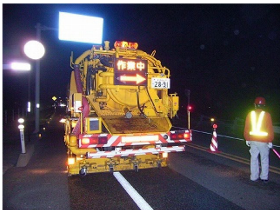
写真-1 排水性舗装清掃作業
