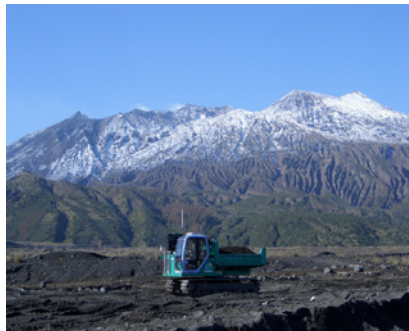
写真－6 土砂運搬状況
