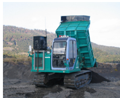
写真－7 土捨て状況
