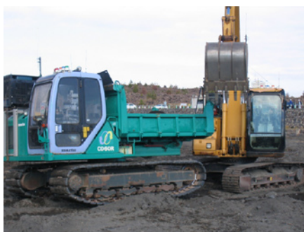
写真－5 土砂掘削積込み状況
