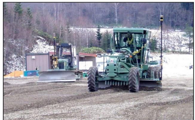
写真1 高精度GPSグレーダによる現場作業状況
