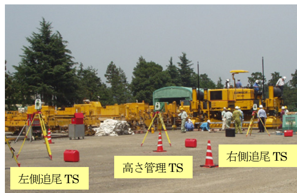
写真－4 TSの配置状況
