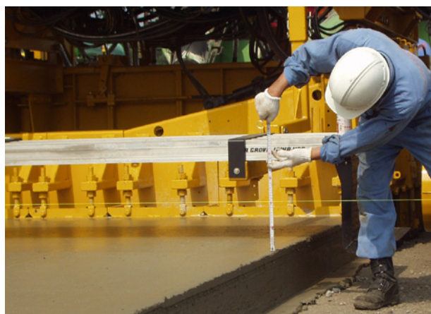
写真－6 水系による高さの確認
