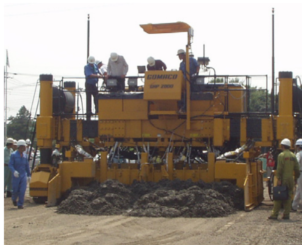
写真－5 前方から見た舗設状況
