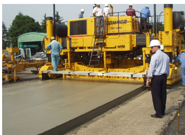
写真－7 敷きならし状況
