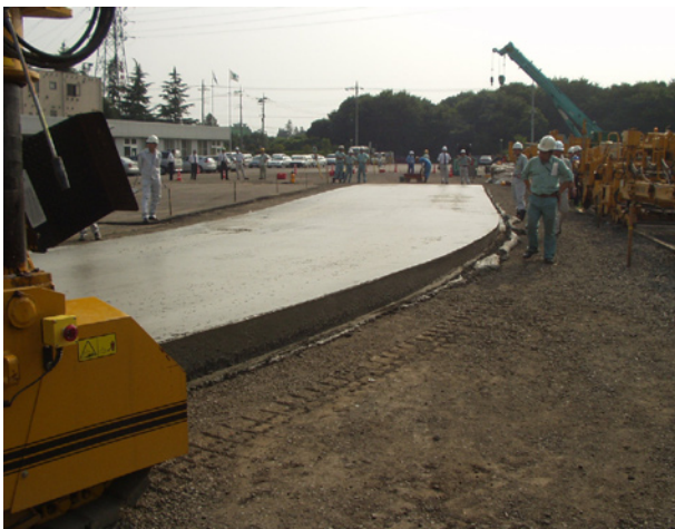
写真-8 舗設後の状況
