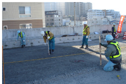
写真-2 現行施工による路盤の出来形確認
