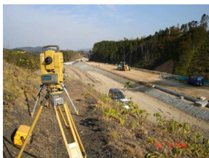
写真-3 情報化施工の路盤整形作業
