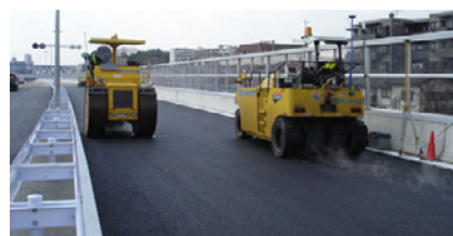
写真-1 試行工事対象現場
