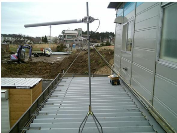
写真 2 受信側アンテナ（指向性）設置例
