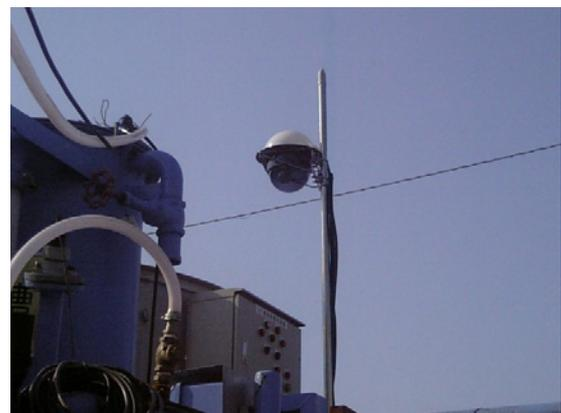
写真7 濁水監視用WEBカメラ
