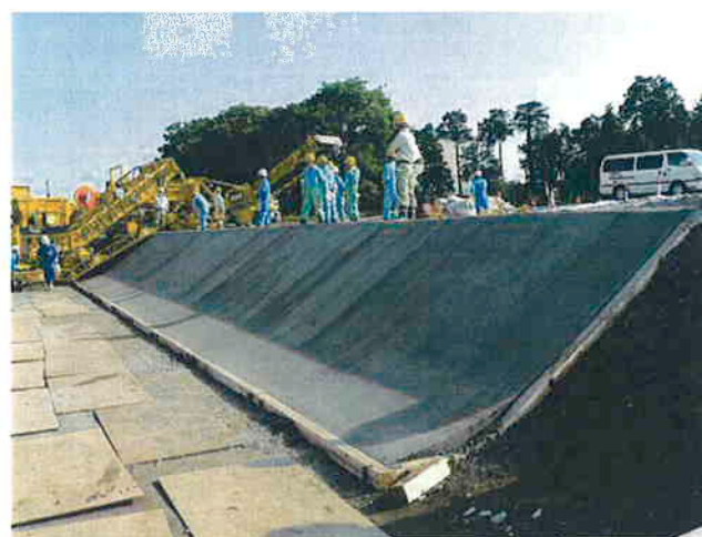
写真-8 打設完了
