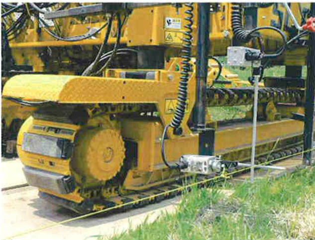
写真-3 ステアリング及びグレードセンサ
