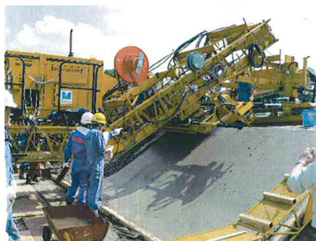
写真-7 後方から見た施工状況
