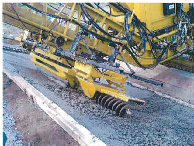
写真-6 オーガ及び、シリンダ部施工状況
