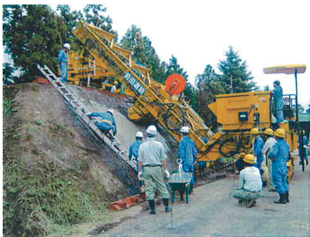
写真-4 後方から見た施工状況
