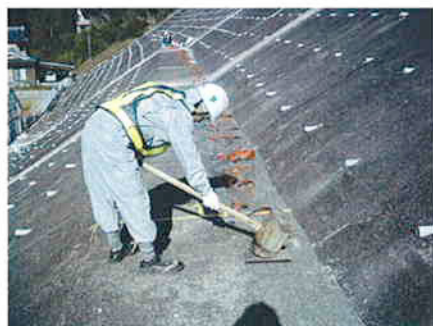
写真5 表面波探査状況
