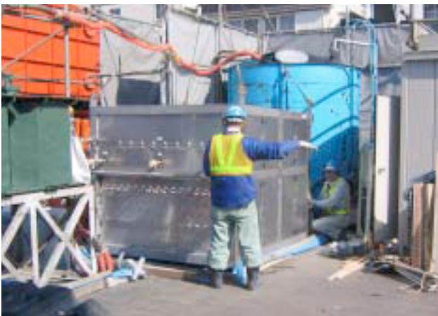
図-5 多連注入ポンプの設置例
