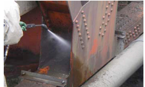
写真-7 トラス部材格点部の洗浄
