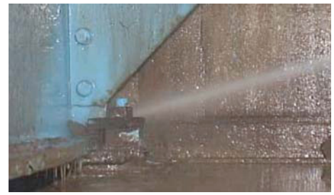
写真-6 支承周りの洗浄
