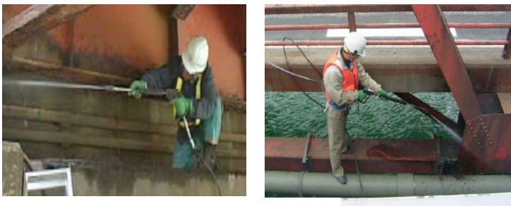
写真-5 洗浄作業
