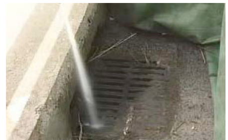
写真-8 排水ますの洗浄
