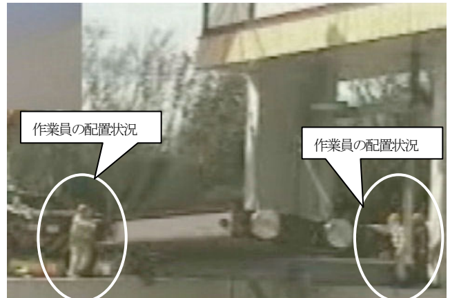
写真-6 扉体の吊り上げ状況の画像
