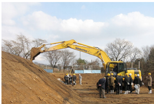
写真－1 試験ヤードにおけるバックホウの情報化施工（試験施工）の様子
