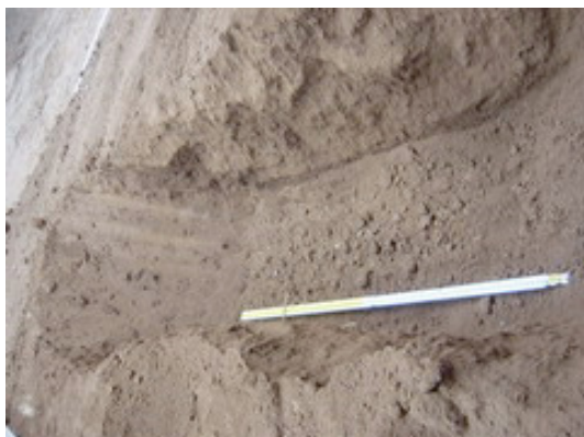
写真－２ 連続掘削後の仕上がり状態
