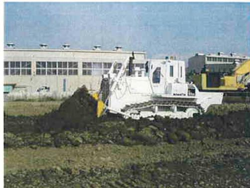
写真 22 ブレードによる整地作業
