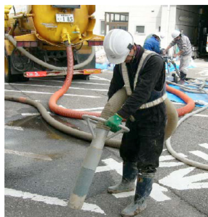
写真－5 既存装置
