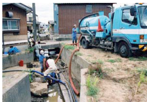
写真－3 汚泥吸引車による作業状況
