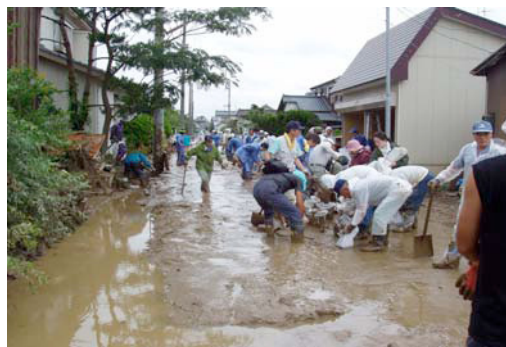
写真－1 人海戦術による排泥作業状況
