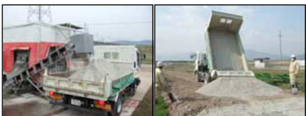
写真-5 固化材積込
