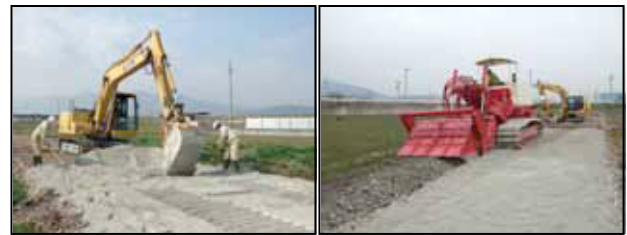
写真-7 固化材敷き均し
