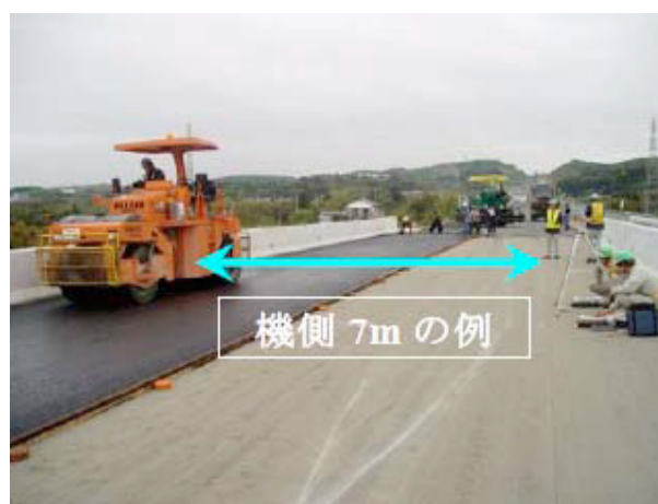
写真3 橋梁上部での騒音・振動測定の場合
