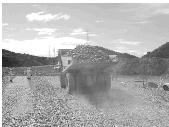
図9 現場施工試験
