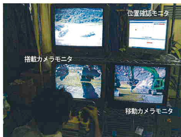
施工状況（遠隔操作室）
