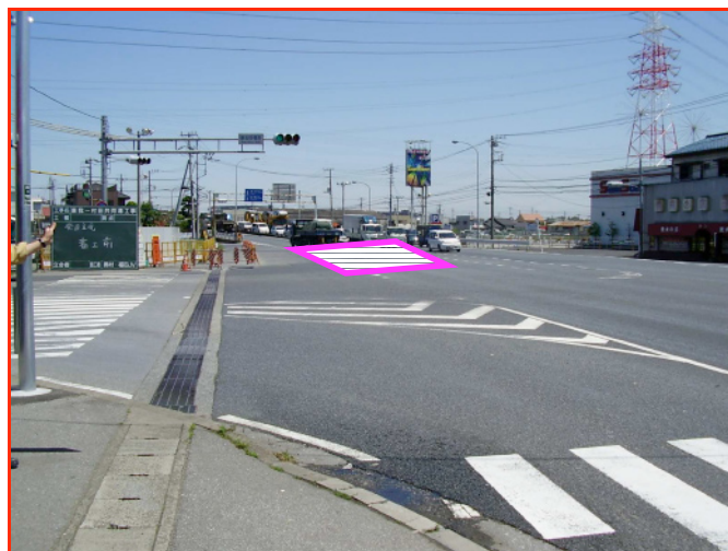
写真-1 発進立坑部全景 (他社施工済)
