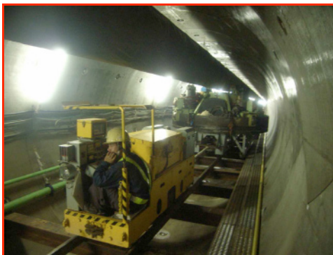
写真-10 駆動部運搬状況
