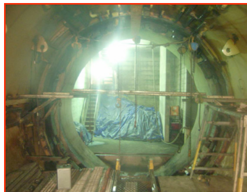
写真-11 カッタヘッド内殻・中殻撤去完了
