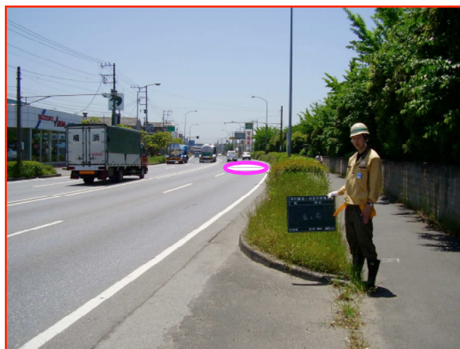
写真-2 中間立坑部全景 (着手前)
