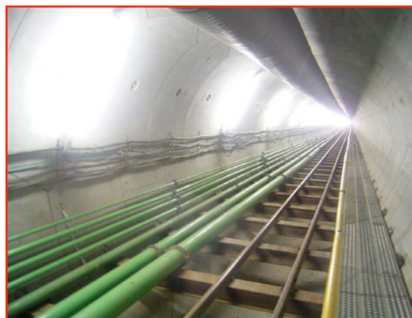
写真－５ トンネル全景
