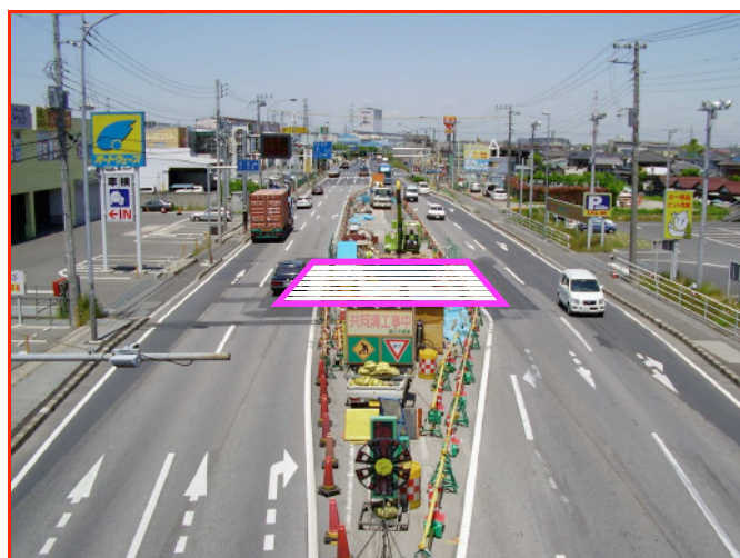
写真-3 到達立坑部全景 (他社施工中)
