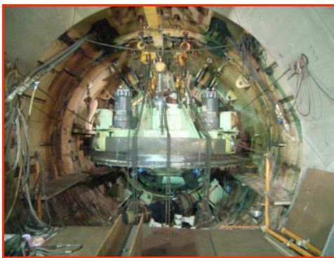
写真-9 駆動部引き抜き・反転完了
