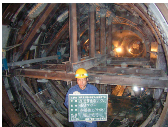
写真-4 既設管補強
