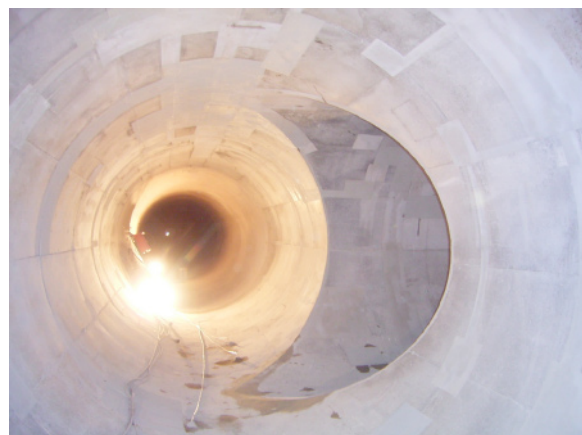
写真－5 完成状況
