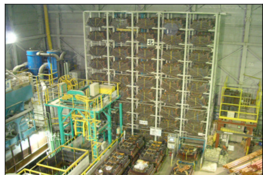
写真-1 セグメントラック
