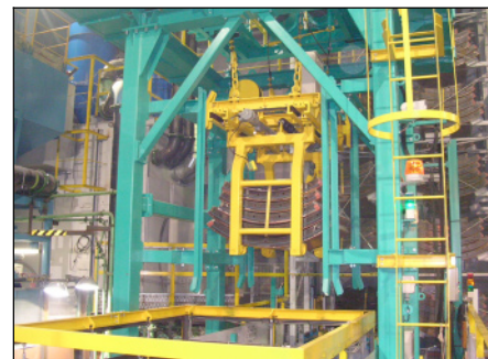
写真-3 セグメントリフター
