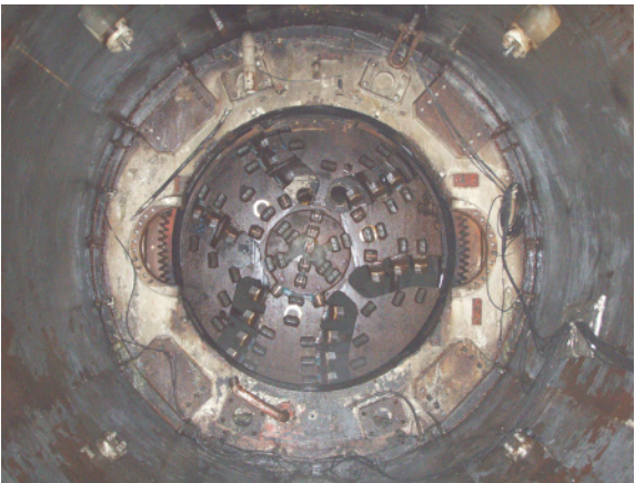
写真-6 地中接合状況
