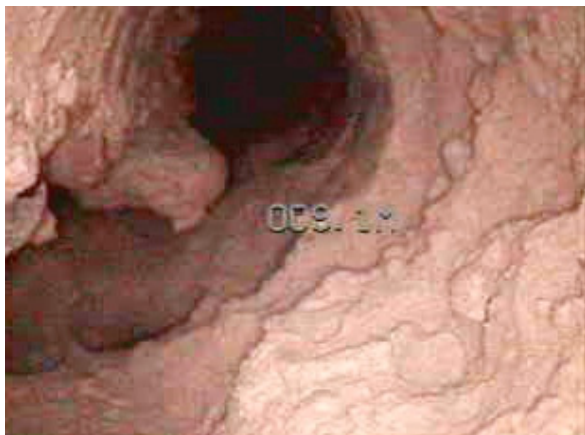
写真-4 孔内写真（従来工法）
