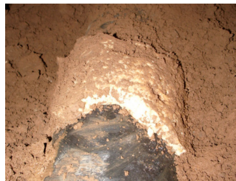
写真-6 鋼管周辺のシリカレジン付着状況（従来工法）
