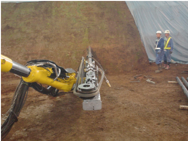
写真－3 試験施工状況
