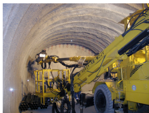
写真－８ 現場施工状況
