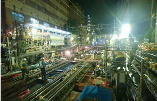
写真－3 地下化切替状況
