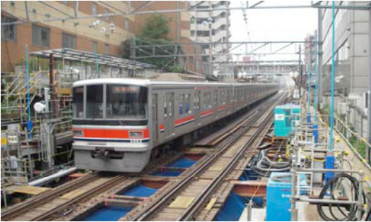
写真－2 地下化切替前
