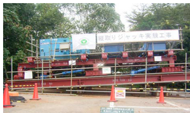
写真－１ 実験施工状況
