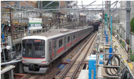
写真－4 地下化切替完了
