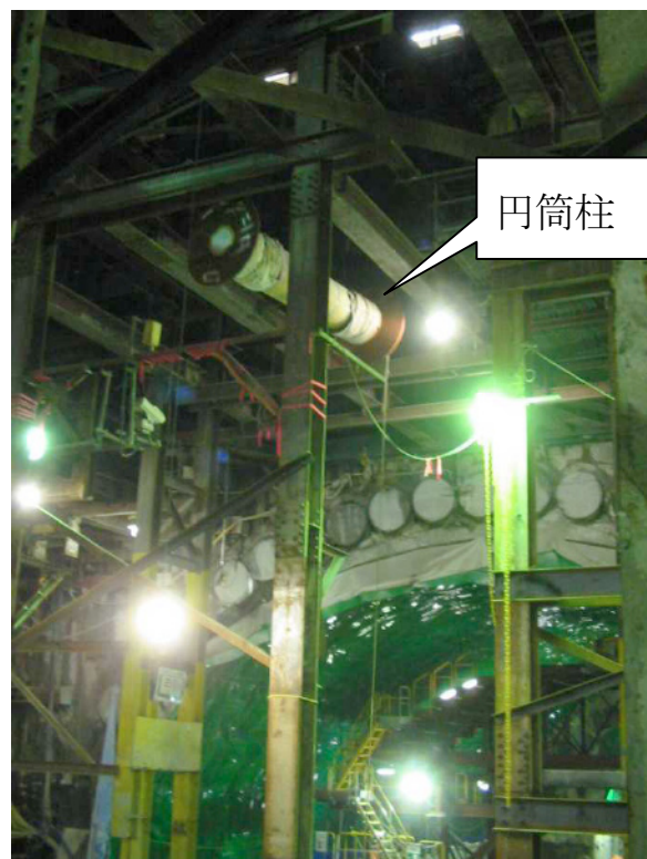
写真-2 地上開口部から搬入中の円筒柱
