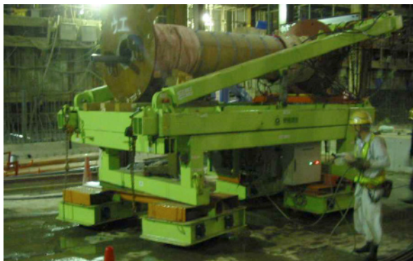
写真-7 円筒柱運搬状況(前方)
