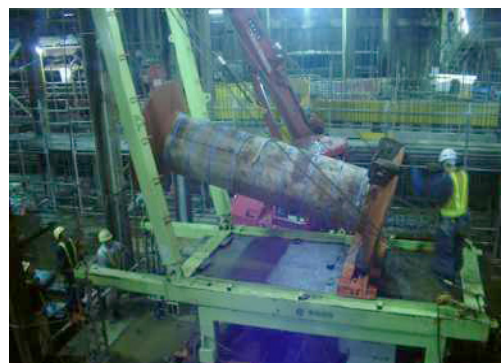
写真-9 建起し状況 下部スライド装置
