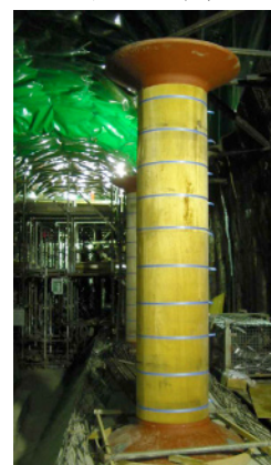
写真-11 建て方終了
