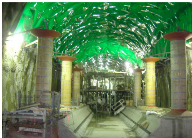
写真-1 建込み終了後の円筒柱
