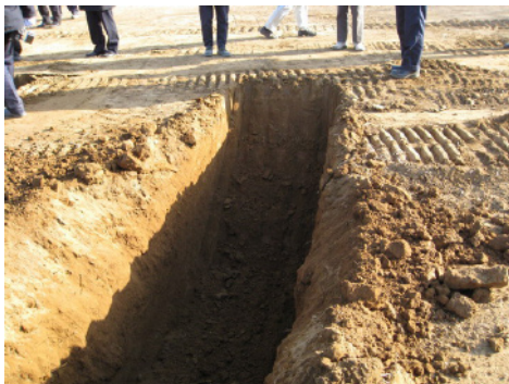
図-12 自動掘削作業終了後の出来形
