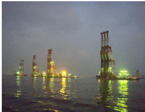
写真-2 : 夜間施工状況
