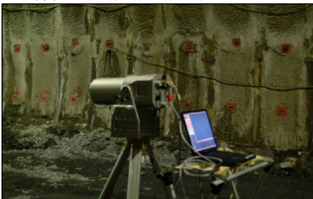
写真－4 3次元レーザースキャナー設置状況 （横向き配置）
