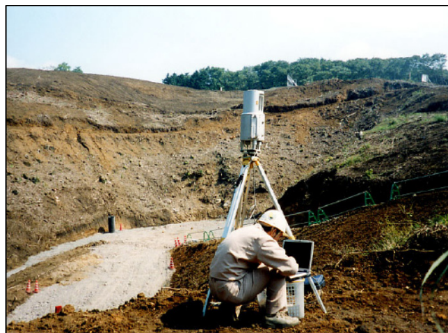
写真－2 3次元レーザースキャナーでの計測状況
