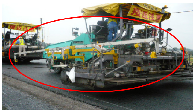
写真－3 フィニッシャへの、超音波多連式取付状況
