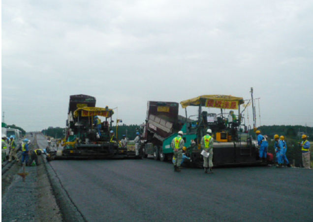
写真－4 施工状況
