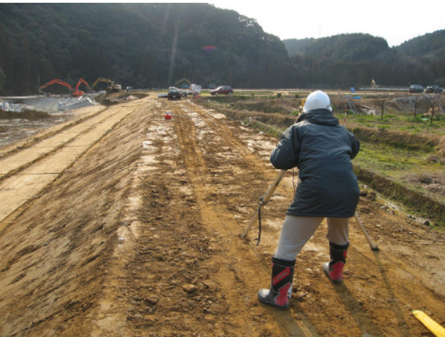
写真-2 現場計測状況（九州）
