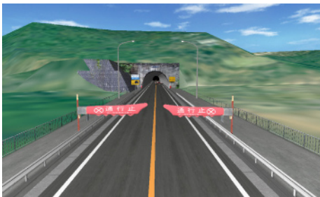
(c) トンネル部での交通規制
