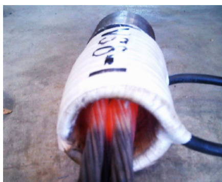
写真-1 PC鋼線加熱状況
