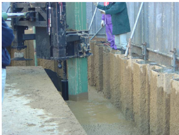
写真-6 シートの角付け作業状況
