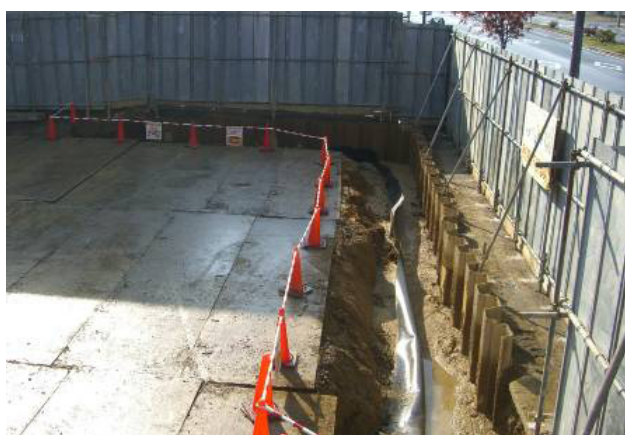
写真-7 角付け施工完了状況
