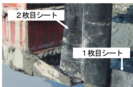
手順3：継手施工
