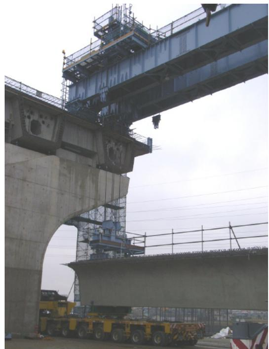
写真-4 U桁吊り上げ状況
