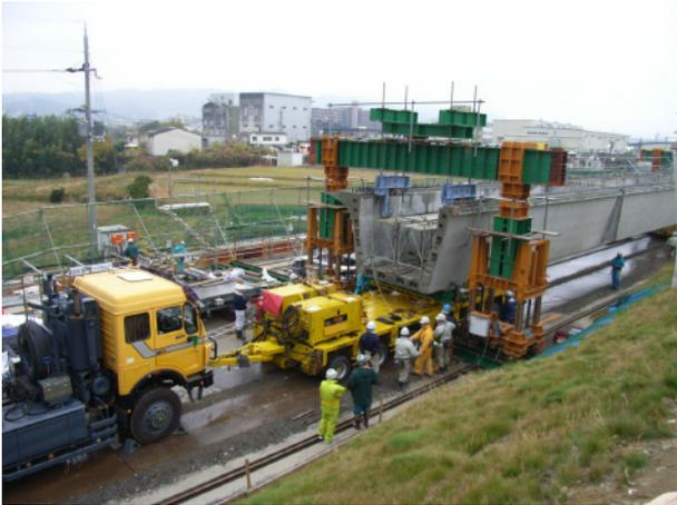
写真-1 U桁積み込み状況
