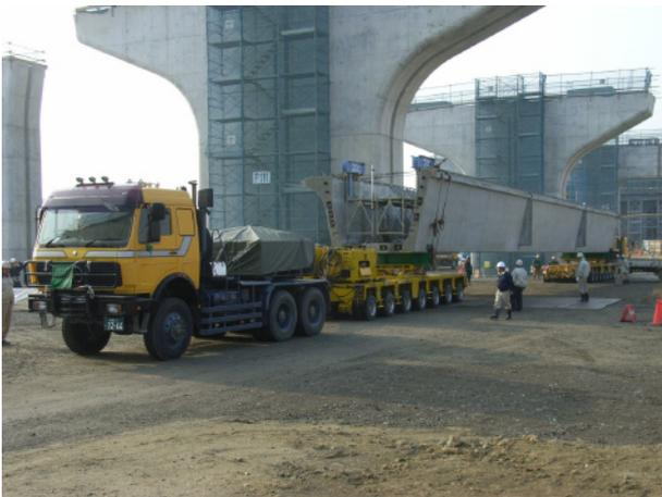
写真-2 U桁場内運搬状況
