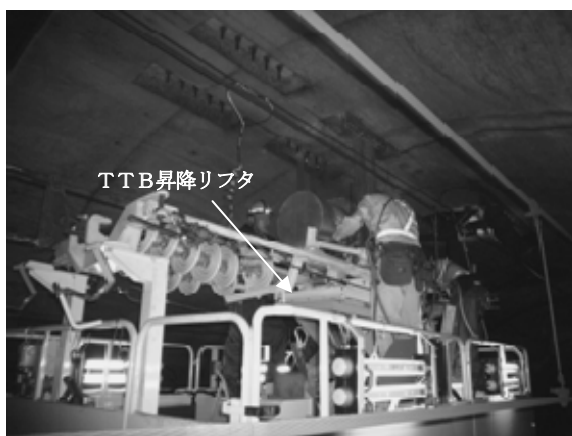
写真7 リフタによるTTB取り付けの様子
