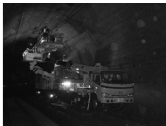
写真 5 TTB 新設施工中
