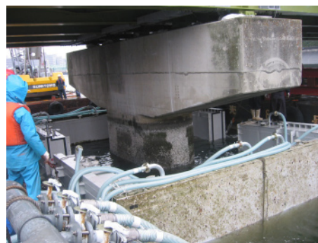
写真-3 函体据付状況
