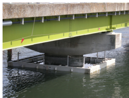
写真-4 沈設完了
