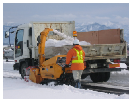
写真4 積み込み試験状況
