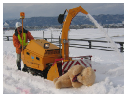
写真5 オーガ安全カバー機能確認
