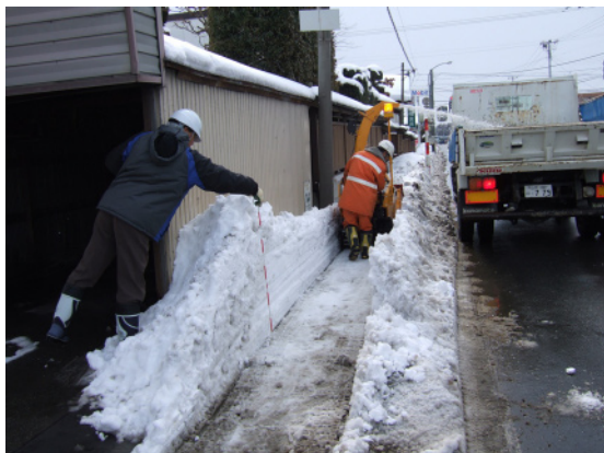
写真6 現場適応性試験状況
